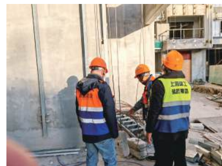
安全周会及现场隐患排查
