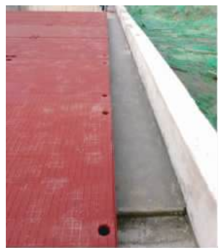
素混凝土填缝定位示意图
